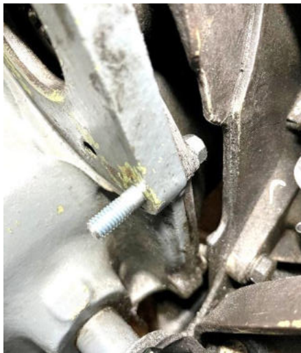
Foto 4: neuer Bolzen eingesetzt
