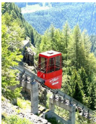
Standseilbahn Mini Funic
